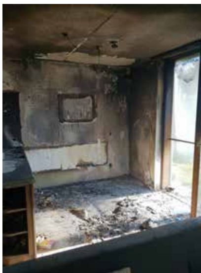
Brandauslöser mobiles Klimagerät: Die Lüftungsöffnungen müssen immer frei bleiben, sonst kommt es zur Überhitzung!
