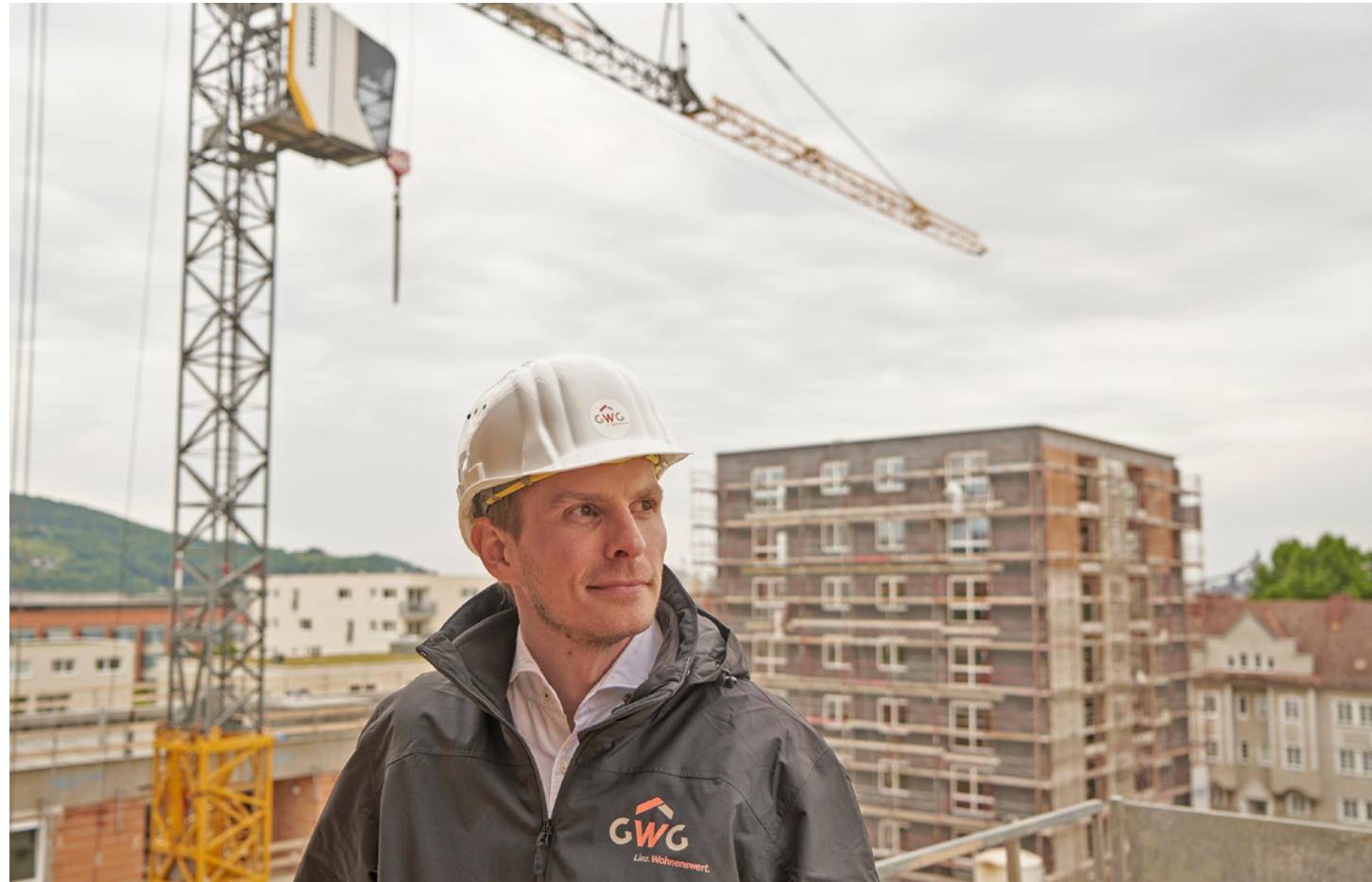
Stefan Gritsch beim Baustellenbesuch in Wimhölzel-Hinterland
